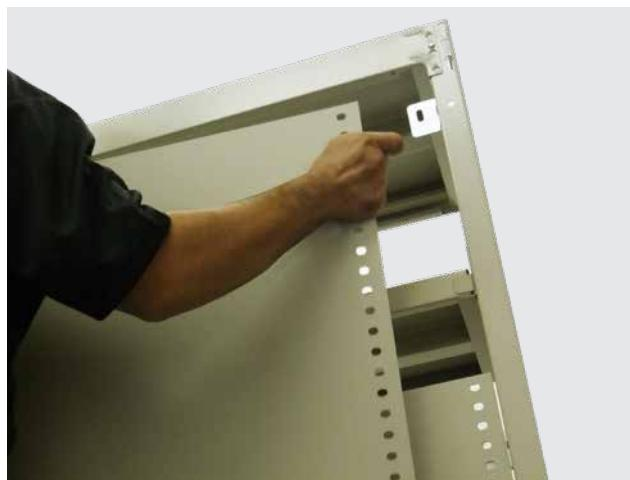
背パネルが2枚以上ある場合は、まず下側のパネルを仮締めした後に上側のパネルを下側のパネルと重ね合わせてボルトナットで一緒に仮締めします。
